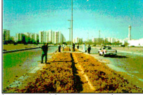
شكل رقم ( ٢ ) يوضح عملية إعداد الحفر للزراعة في الجزر الوسطية في الشوارع
