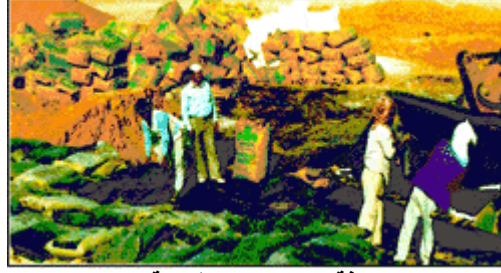
شكل رقم ( ٣ ) يوضح إضافة المحسنات الطبيعية لتحسين خواص التربة
